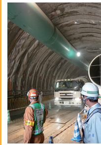
天栄村鳳坂トンネル
